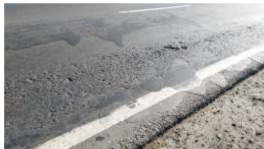
Gambar 13. Retak Kulit Buaya
