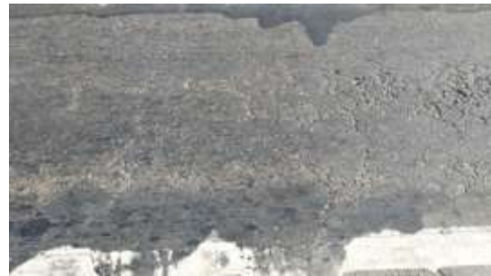
Gambar 21. Retak Kotak-Kotak
