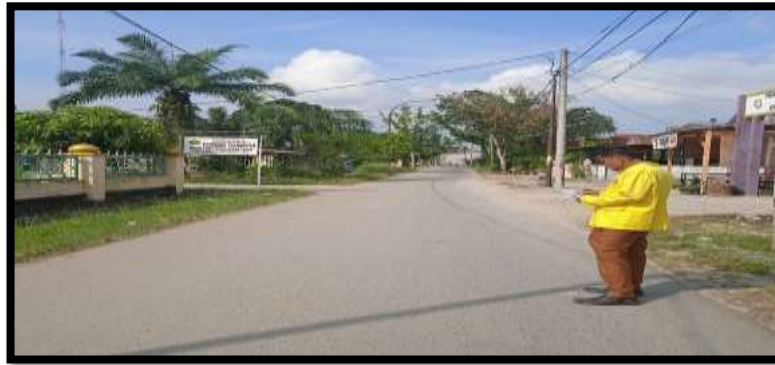
Gambar 3. Foto Kondisi jalan Ruas Jalan SMU 3 STA 0+000-0+200
